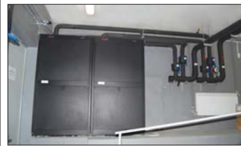
Система распределения хладагента для архитектуры APC InRow RC позволяет гибко наращивать мощность по кондиционированию в горячем режиме. CDU и бесшовные трубы сводят к минимуму риск протечек
